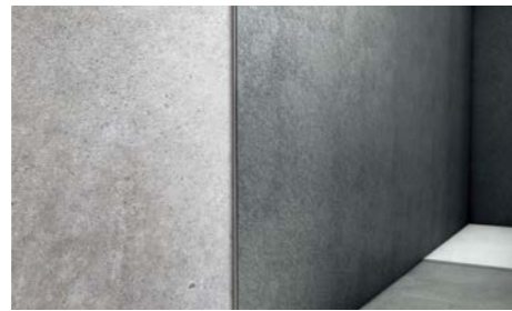
On a new wall 水泥墙上安装
