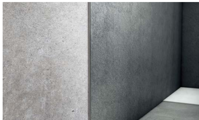
On a new wall 水泥墙上安装
